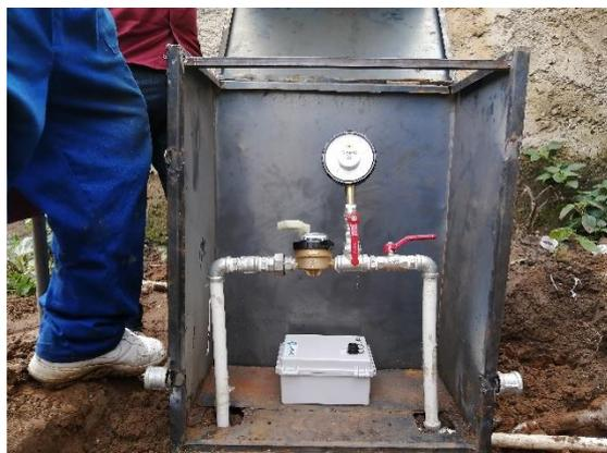
ルワンダにおいて設置された SIRC デバイスを搭載した圧力計と水道メーターの様子。各計器から圧力と流量のデータを送信しています。
